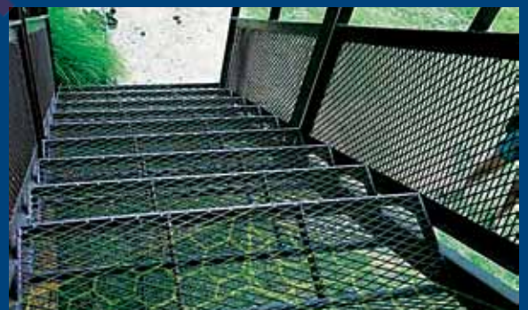
ระเบียงกันตก และราวบันได ใช้ตะแกรงฉีก และตะแกรงเจาะรูทำใ้ดูสวยงามและมีน้ำหนักเบา
